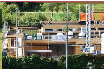
Das zukünftige Haus im Rohbau
